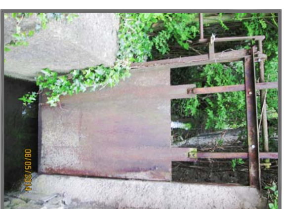
Löschwasserentnahmestelle
