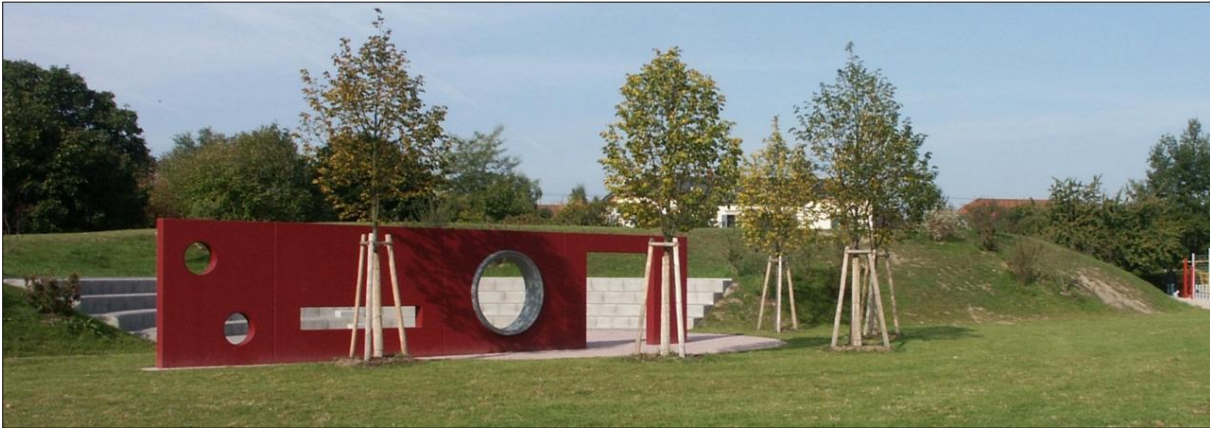
Abbildung 33: Kies-Wasser Erdbecken in Eggenstein. Bildquelle: Universität Stuttgart, Institut für Gebäudeenergetik, Thermotechnik und Energiespeicherung.
